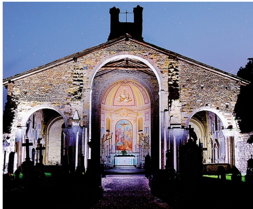
La Basilica di Santa Giulia a Bonate Sotto: partiti i lavori di restauro
